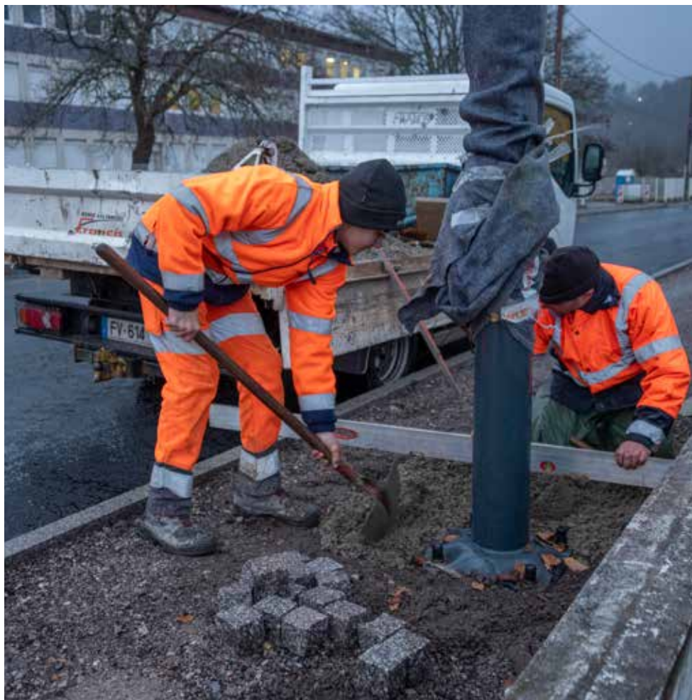
Rue du 12 e -Régiment-d'Artillerie, les travaux touchent à leur fin.
